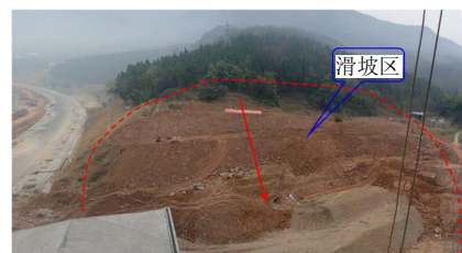
图 14 万源新区 6 号道路 3 段滑坡全景
